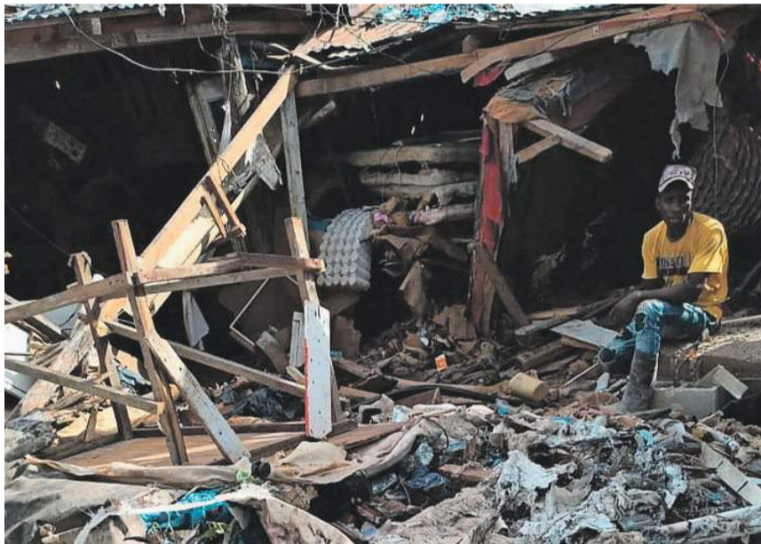
Grosse Sturm- und Regen-Schäden in der Dominikanischen Republik.
